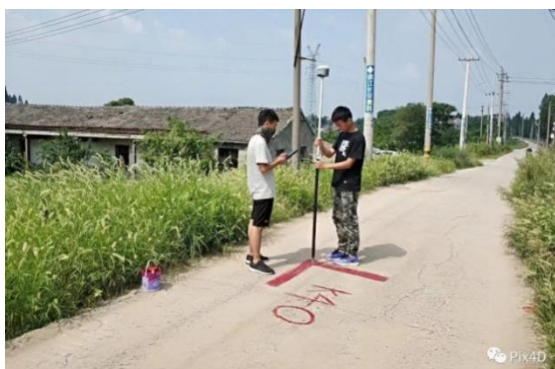
图 4-5 像控点测量示例
